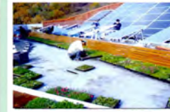
▲초박형·비관리형 식생유니트 포설
